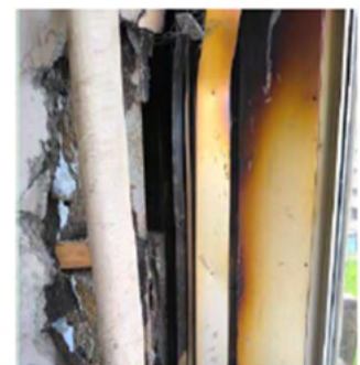
旧ボンベ室と火元室の隔壁 (焼損と消火活動に伴う破壊状況) (入口ドア側から)
