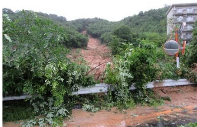
(大学構内の裏山が崩れ、土砂が流出)
