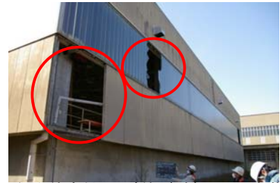
（総合体育館：外壁等が破損、天井も落下の危険があった。）
