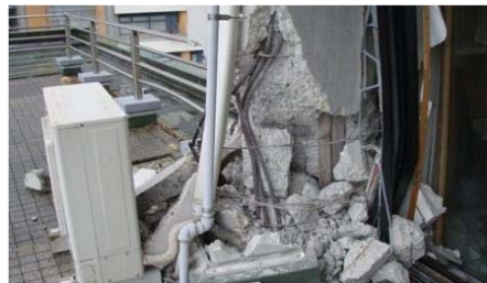
(青葉山キャンパス工学研究科建物の被害状況)
