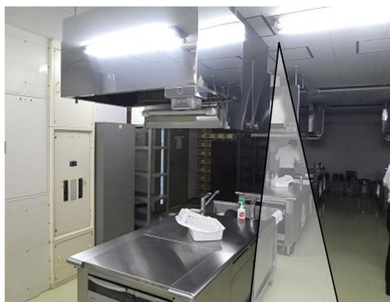
×都市ガスを使用しているがガス漏れ警報器を設置していない
