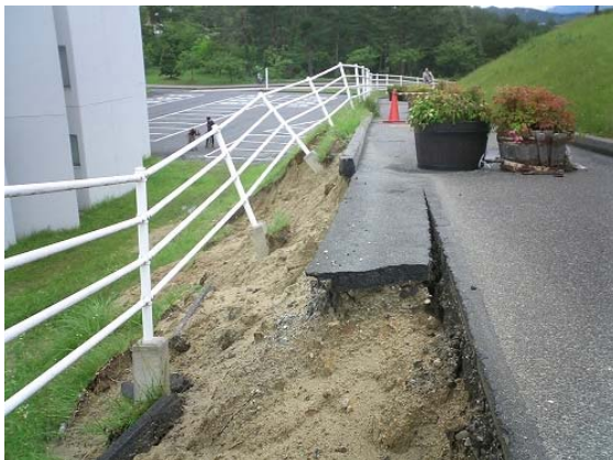
大学構内の法面が一部崩れた。
