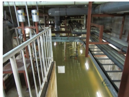
環境安全センターの地下室（タンク・自家発電機）が浸水
